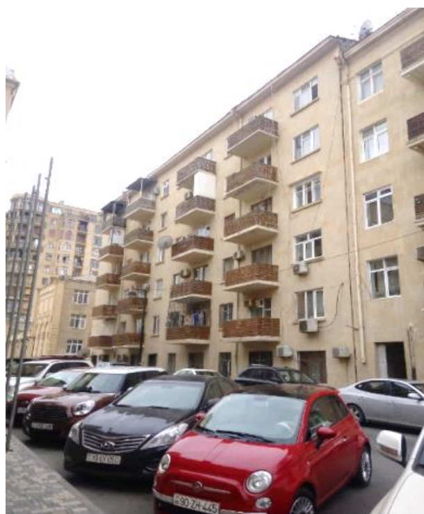
Рис. 3. Бакинская «хрущевка» по улице Ю. Ибрагимли, дом 7. Дата окончания строительства 1963 г.
