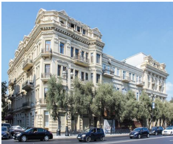
Рис. 2. Баку, Проспект Нефтяников, дом 121, 1897 год. Надстройка 4-го этажа осуществлена в 1958 г.
